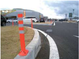
静岡県 足柄 SA 段差注意喚起
