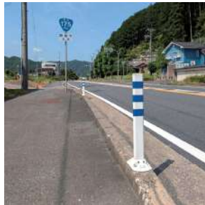
京都府 国道175号 視線誘導
