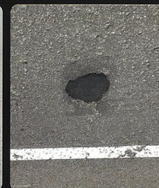
車道ポットホール補修
