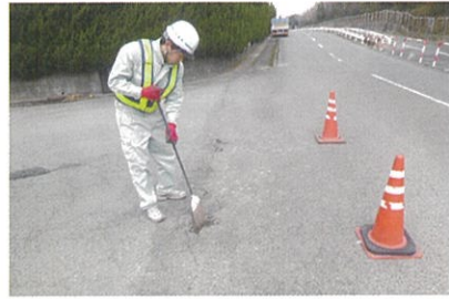
2 補修前にゴミや砂などを取り除きます。
