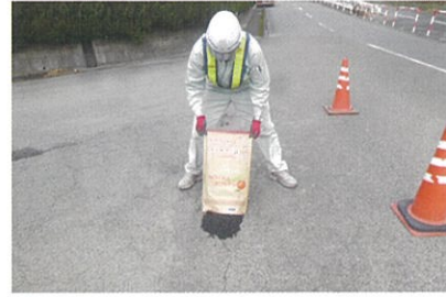
3 補修箇所にオレンジパッチを充填して下さい。
