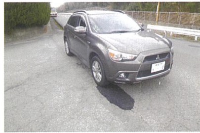
5 補修後直ちに車両の通過が可能です。通過車両の転圧で強度が増強します。
