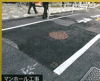
マンホール工事
