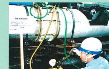
外水圧試験状況
