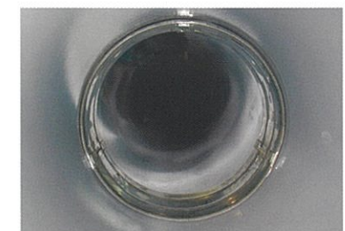
マグマロック設置後の状況
