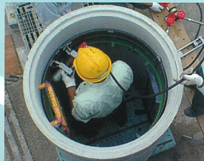
マグマロック(マンホール用)拡径作業状況
