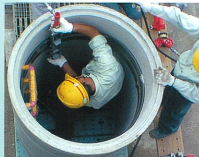
マグマロック(マンホール用)固定作業状況
