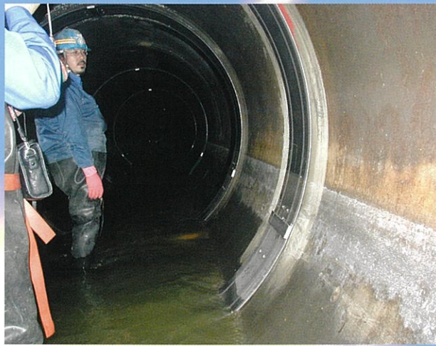
スナップロック工法ML 事例:φ2200mm
