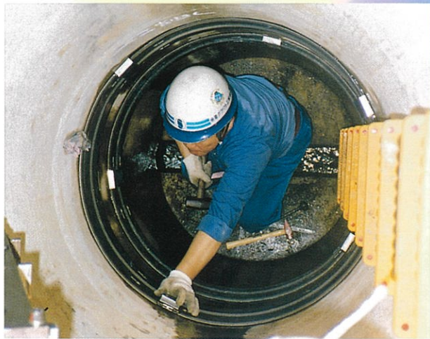
マグマロック工法 事例:マンホール内施工
