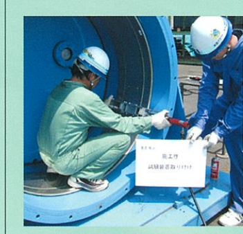
内水圧試験装置 取付状況
