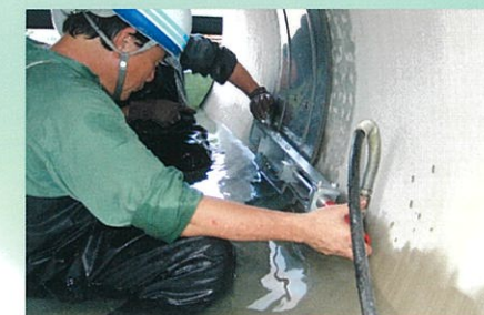
水深340mmでの施工状況
