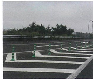
三陸自動車道
