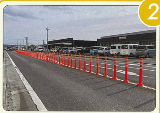
2 中央分離 中央線を明確にします。U ターン防止や追い越しなど対向車線へのはみ出しを抑制します。
