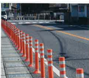
岡山県 国道 181 号
