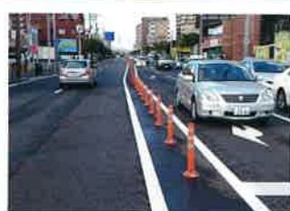
福岡県 国道3号
