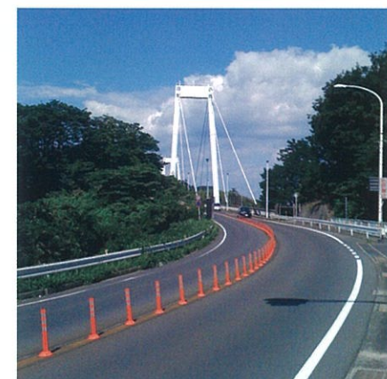
広島県 尾道大橋
