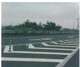
三陸自動車道
