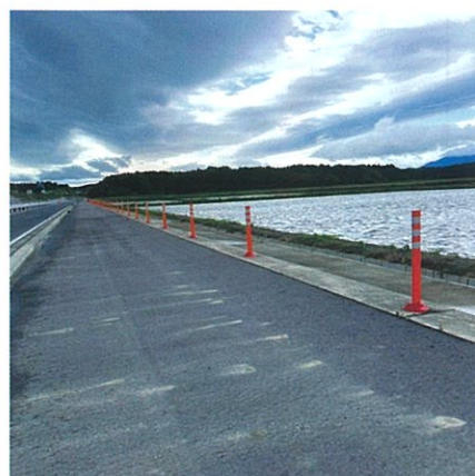
三重県 国道 23 号側道
