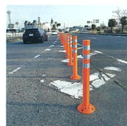
長崎自動車道 佐賀大和IC 逆走対策
