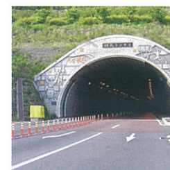
長野県 湖北トンネル
