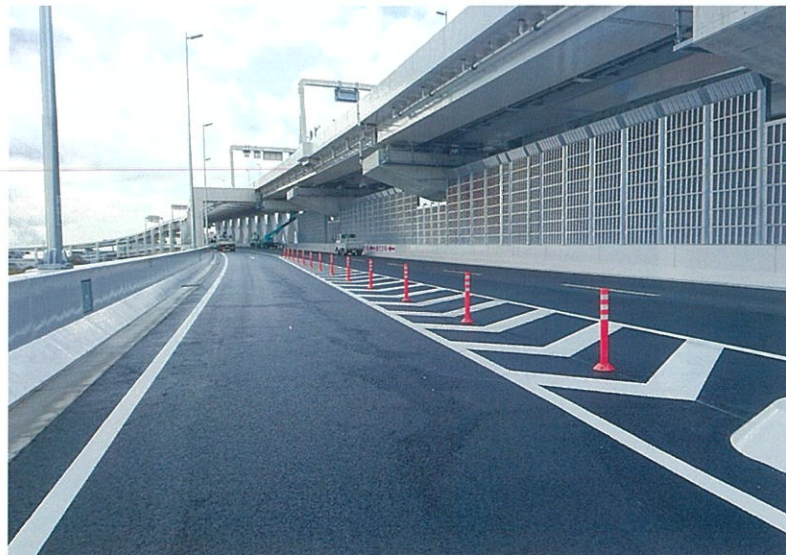
首都高速道路 横浜環状北線
