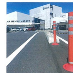
神奈川県横浜市 商業施設
