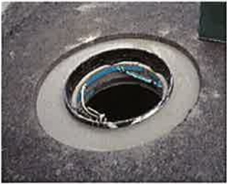
無収縮モルタル打設
