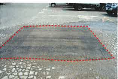
駐車場の補修に
