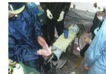
光硬化 施工機
