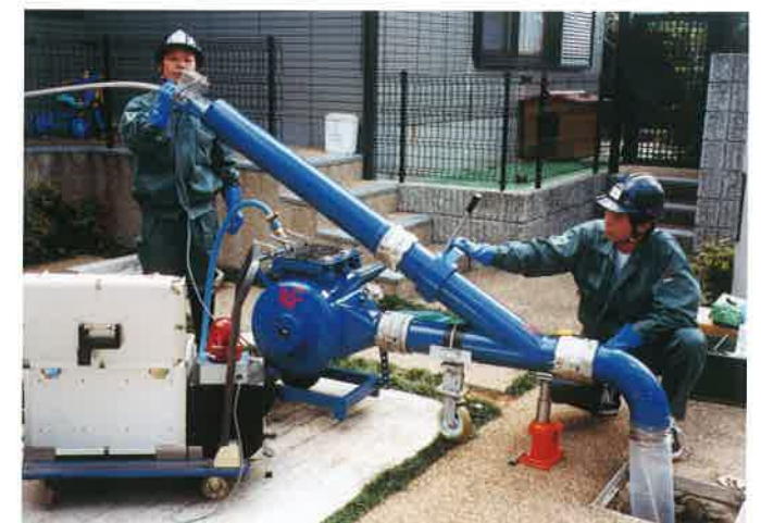
施工状況(公共ます)
