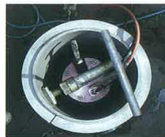
施工状況(小型ます)
