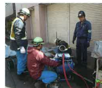
指導員による施工管理チェック
