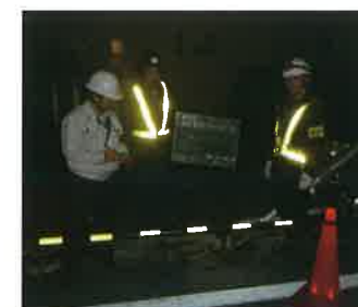
夜間 安全・施工パトロール
