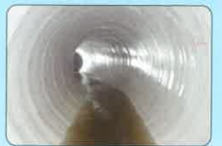
屈曲部への施工
